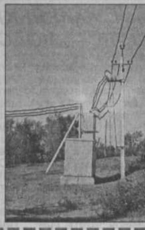
одна улица в г. Сибай имеет такую линию электропередач. Стоимость СИП гораздо выше обычных низковольтных изолированных проводов, но это компенсируется рядом существенных преимуществ, таких как повышение качества переданной энергии при той же нагрузке, улучшение рабочих условий за счет устранения возможности контакта с посторонними предметами, полная защищенность от воздействия влаги и коррозионная устойчивость и др., а самое главное — это безопасность.
