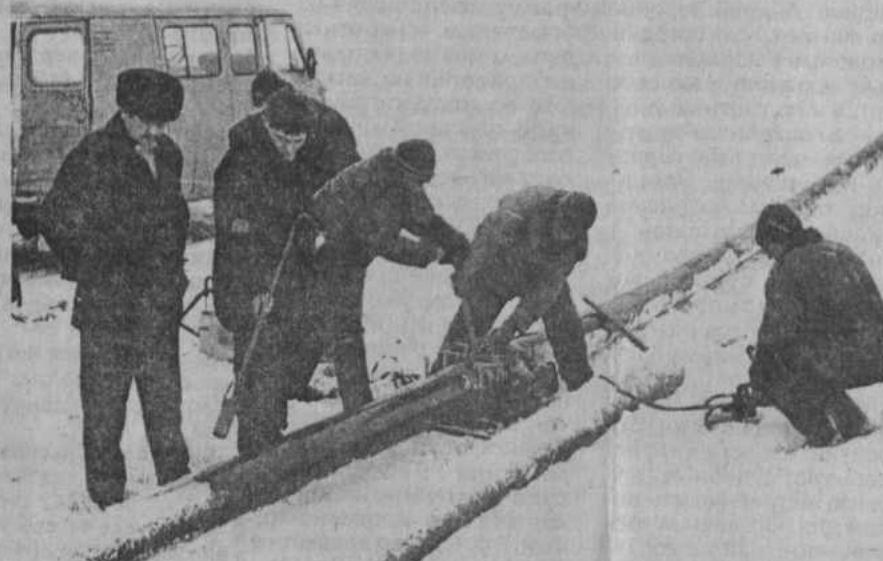
Ф.Н.Батанов со строителями водовода Акъяр-Макан на участке, где проводится сварка полизтиленовых труб.
