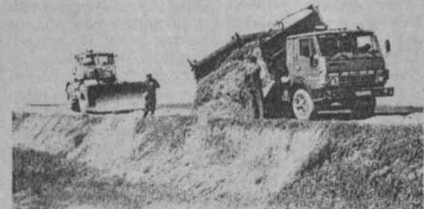
Идет засыпка автодороги Маман-Мамбет.
