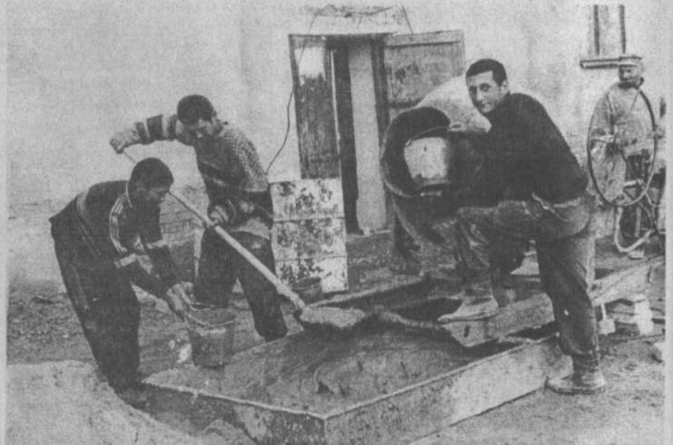
Добросовестно работают на реконструкции здания во время каникул студенты И.Н.Кудашев, И.Ф.Кудабаев. Д.Тумениян вместе со студентами готовит строительный раствор.
