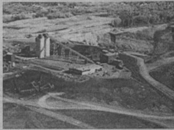
Учалинский цементно-известковый завод.
