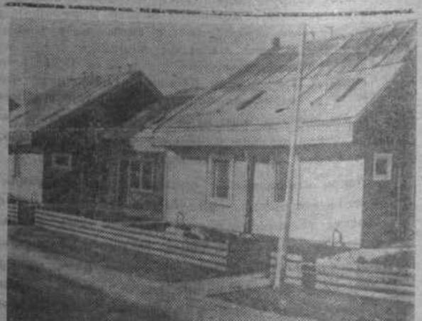
В одном из районов Будапешта на крышах домов стали устанавливаться солнечные батареи. С их помощью эти дома обеспечиваются горячей водой и отоплением.
