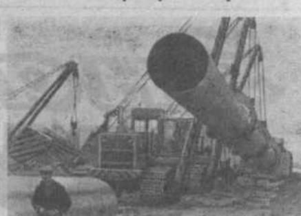
Тюменская область. Продолжается освоение Уренгойского газоконденсатного месторождения. Отсюда берет начало газопровод Уренгой—Новоуральск, входящий в систему крупнейших магистральных трубопроводов Западной Сибири — Центр. Сейчас здесь идет изlayка труб диаметром 1420 мм. Одновременно со строительством этой магистрали коллектив треста «Уренгойгазобурострой» приступил к подготовительным работам на прилегающем участке экспортного газопровода Уренгой — Ужгород.
