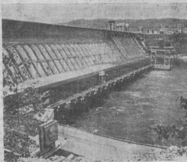
Счетчики Красноярской ГЭС зафиксировали цифру: 150 миллиардов. Столько киловатт-часов электроэнергии выработала станция почти за 10 лет работы. На Красноярской ГЭС установлено 12 агрегатов мощностью по 500 тысяч киловатт каждый.
