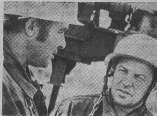
НА ВЕРХНЕМ СНИМКЕ: бригадир И. Федюшкин (слева) и монтажник А. Родионов на испытаниях переставляемой опалубки.
