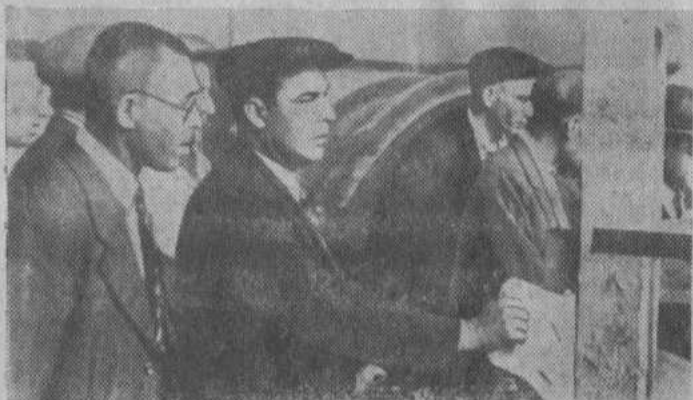
Запорожье. 1947 год. Л. И. Брежнев (в центре) в период восстановительных работ на заводе «Запорожсталь».
