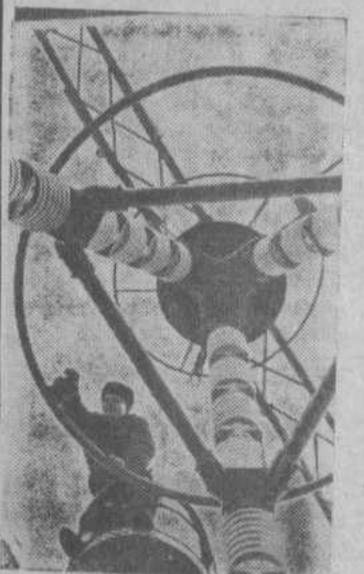
Отлично трудится на сооружении распределительного устройства Рязанской ГРЭС электромонтажник из управления № 2 треста «Электроцентромонтаж» Н. И. Ситов. Сейчас он монтирует подвесной разъединитель на 500 киловольт. Передовой монтажник выполняет дневные задания на 150—160 процентов.
