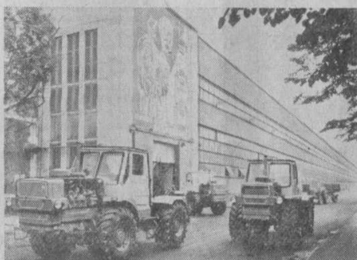
На Харьковском тракторном заводе построен гигантский цех, где расположен главный конвейер по сборке трактора «Т-150». На предприятии развернулось соревнование за досрочное освоение новых мощностей и наращивание темпов выпуска новой машины.
