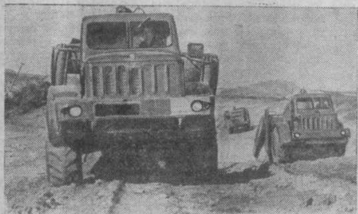
Куйбышевская область. Широко развернулись работы на строительстве Куйбышевского обводнительно-оросительного канала. Его первая очередь — 50 километров — должна быть заполнена водой в этом году. На снимке: на строительстве канала. Фото А. Брянова. (Фотохроника ТАСС).
