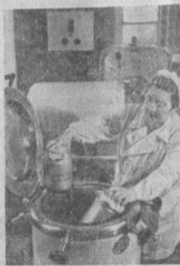
НА СНИМКАХ: (справа) врач Н. В. Епифанова закладывает в автоклав баллоны с питательной средой для выращивания грибов антибиотиков, слева — пробирки с грибами антибиотиков.
