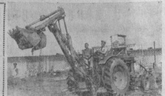
ГВИНЕЙСКАЯ РЕСПУБЛИКА. В городе Маму гвинейские строители в сотрудничестве с советскими специалистами завершают сооружение первого в стране крупного предприятия по переработке сельскохозяйственных продуктов — консервного завода.
