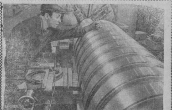
ЛЕНИНГРАД. На Невском машиностроительном заводе имени В. И. Ленина изготавливается вторая газовая турбина мощностью 12 тысяч киловатт. Она предназначена для электростанции, строящейся на нефтепромыслах Небит-Дага в Туркмении. Ротор компрессора высокого давления этой турбины обрабатывает показанный на снимке токарь В. С. Пятанов. ФОТО П. ФЕДОТОВА. (Фотокроника ТАСС).
